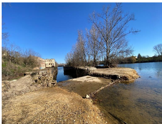
Figure 3 : Vue de la piste d'accès existante © ECCEL Environnement
